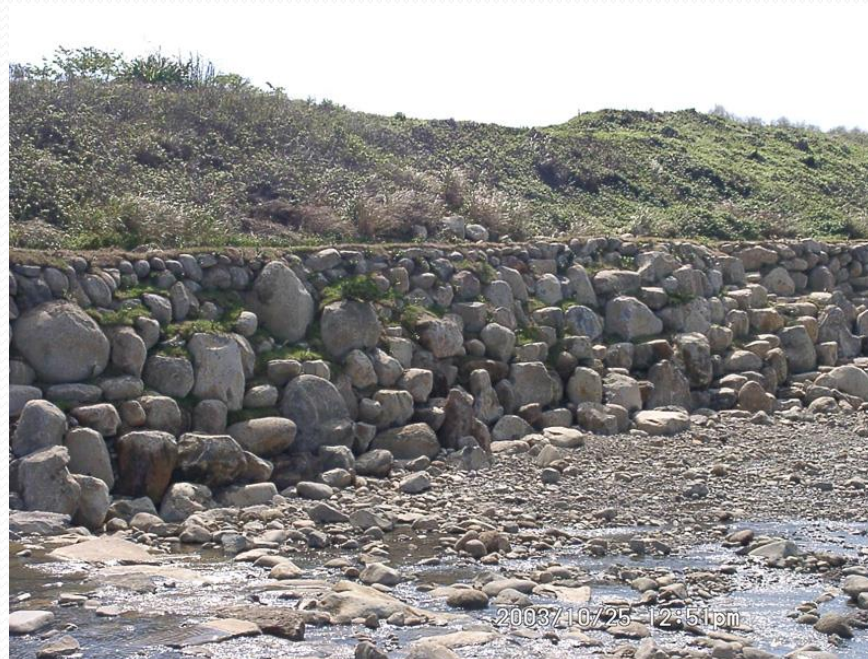
圖五十一、完工後河口護岸之情形
