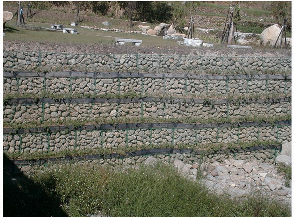
石籠護岸加植生，兼具了美化與穩定的功能
