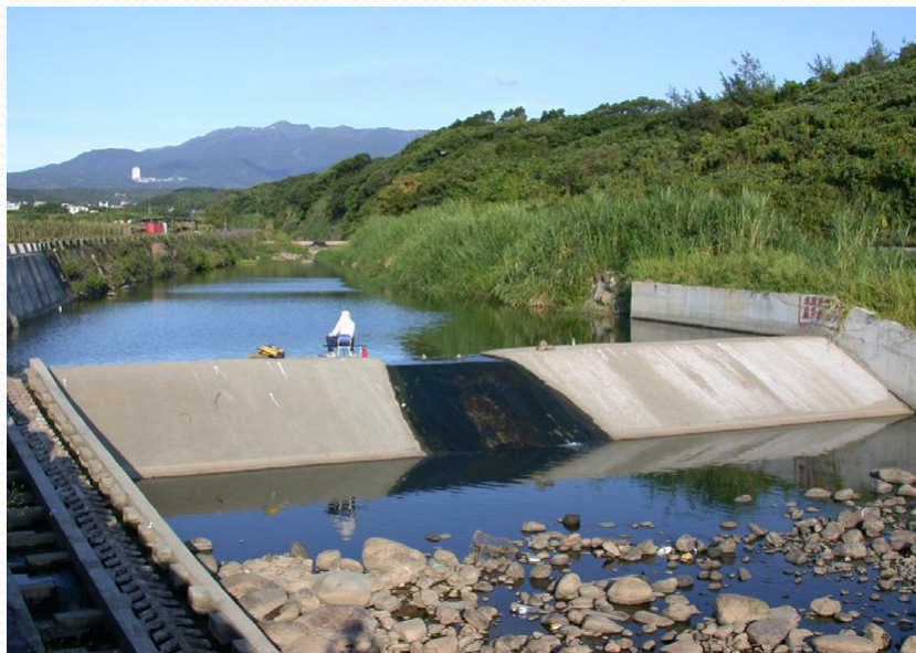
圖四十八、原下游攔河堰對河道阻隔情形
